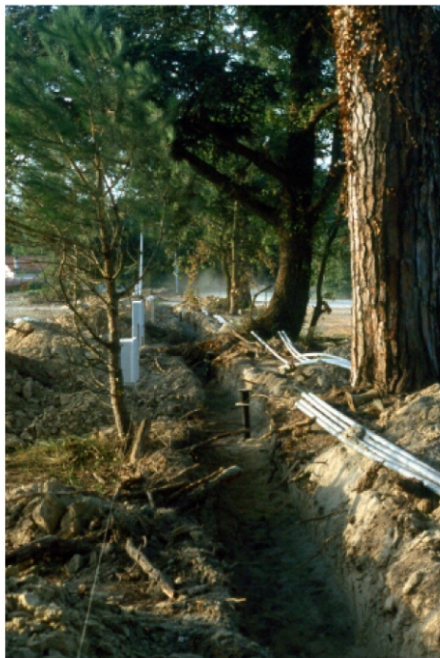
Tranchée endommageant les racines de l'arbre
