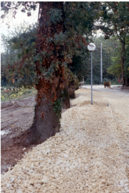
Remblai excessif en pied d'arbre
